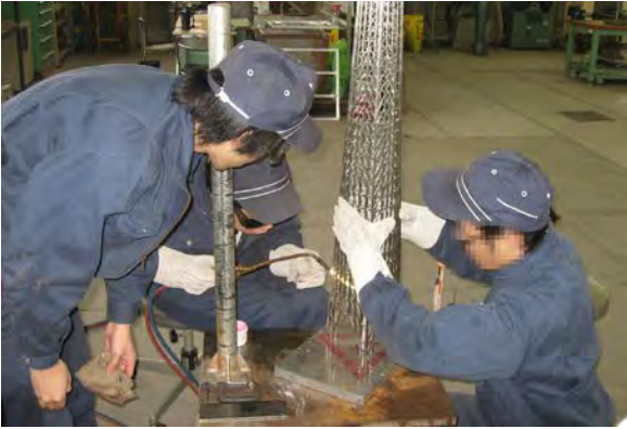
図5 溶接作業(鉄骨部)
