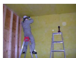
写真1 吸音材施工
