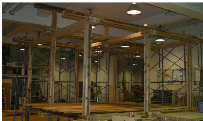
<写真1 観測小屋の軸組の組立>
