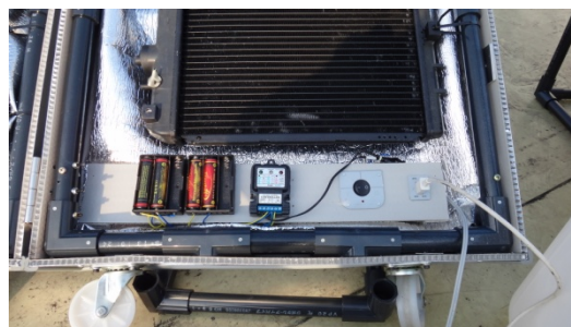
図4 電源部 (リチウムイオン蓄電池)
