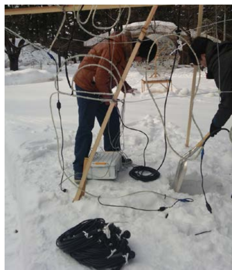
図 4 設置作業風景
