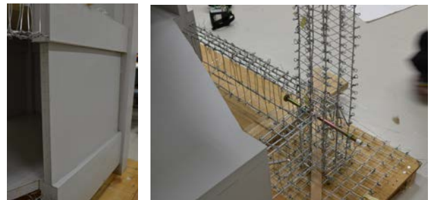
写真3.(左上:柱筋の様子、右上:軸組の塗装、左下:壁の設置、右下:軸組部と鉄筋部の組み立て)
