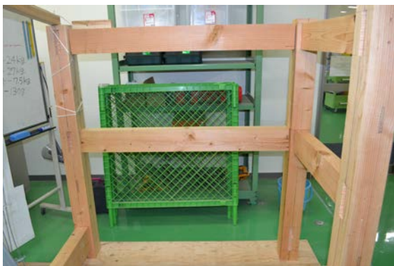
写真1. 軸組部をくみ上げた様子(塗装前)
