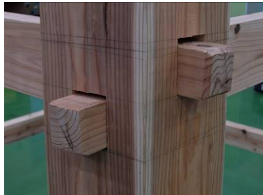
図5 柱と貫の詳細写真
