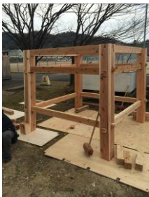
図4 柱と貫の全体写真
